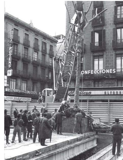
Obras del metro del Liceu. 1968
