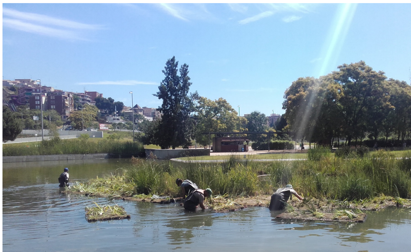
Imatge 20: Col·locació d'illes flotants de vegetació aquàtica al parc de Can Zam (Santa Coloma de Gramenet)
