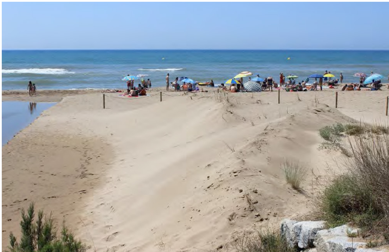
Imatge 80: Formació de dunes al sud de la riera de Canyars (Gavà) per protegir la desembocadura
