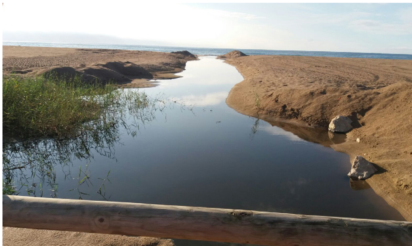
Imatge 79: Sortida de pluvials (Castelldefels)
